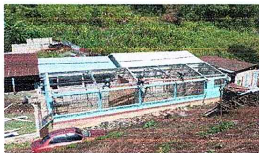
Foto 3: Colocacion de todas las costaneras
