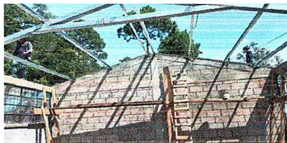
Foto 2: Colocacion de vigas de 3x4.
