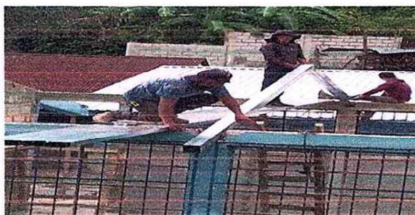
Foto 4: Instalacion de las dos vigas
